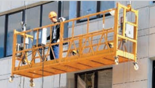
Люльки универсальны в применении за счет секционной конструкции
