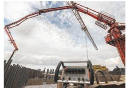
Бетонораздаточная стрела состоит из гидравлической стрелы, опорной колонны и бетоновода. Она оснащена гидравлической системой, имеет электропривод, механизм поворота и механизм подъема стрелы. Начиная с модификации 2013 года стрела не требует противовеса, стала в 2 раза легче и существенно быстрее.
